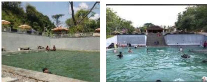
Gambar 18. Belum Ketersedian Rambu Peringatan
